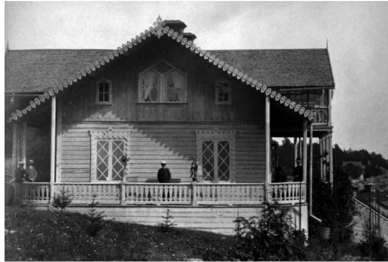
Baldersvägen 28B / Dalarö 6:6 / Byggt 1865.
