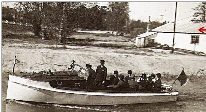
Knut Fredrik Svibergs garage vid Vadet 1938, nu rivet.
