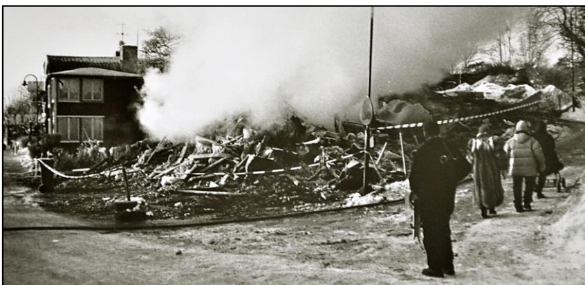
Dagen efter branden, den 23 december, är hela huset borta.
