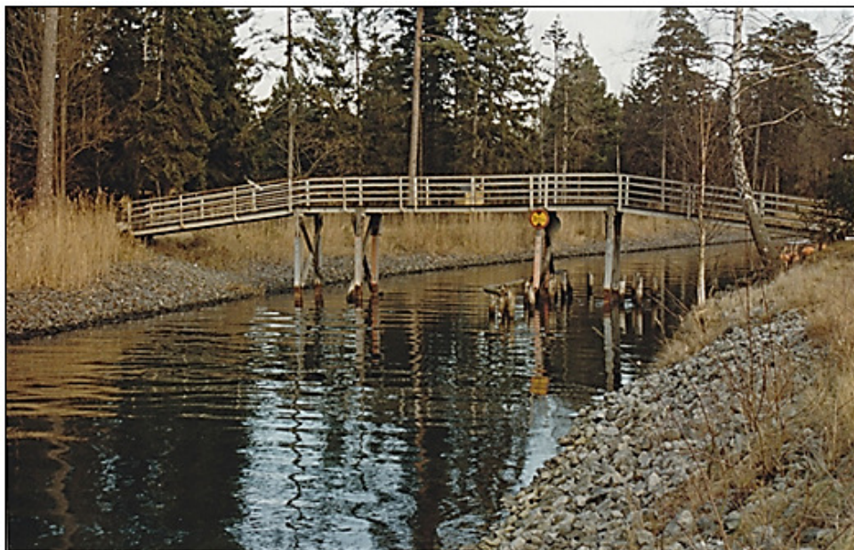
Gamla gångbron från 1938.
