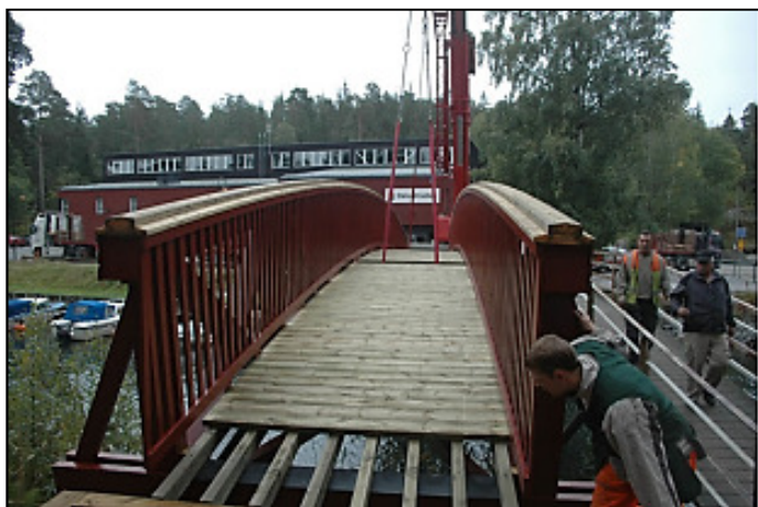
Inpassning av brospannet på fundamenten.
