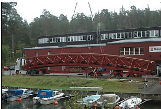
Här lyfts brospannet på plats över kanalen.
