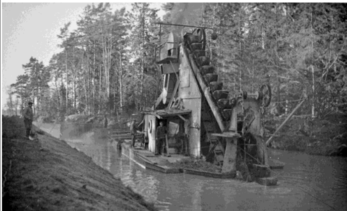
22/34: Kanalbygge med mudderverk. Senare hälften av 30-talet.
