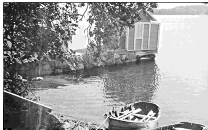
22/37: Ett av badhusen på Dalarö. Baldersvägen 28A. Dalarö 6:44.
