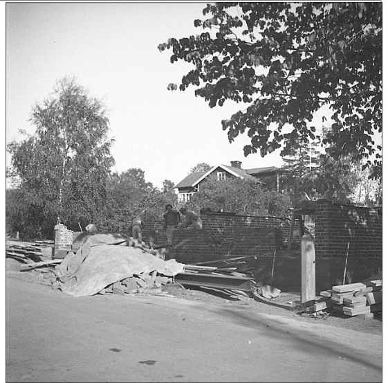
7/7: Byggnation av tegelhuset. År 1944.
