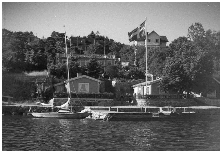
47/2: Familjen Dahlborgs villa sedd från sjösidan. Årtal 1950. Stora gäststugan till vänster.
