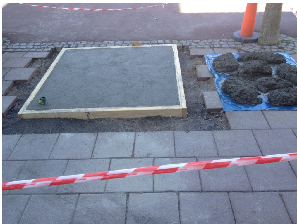
Gjutning av plattan på torget.
