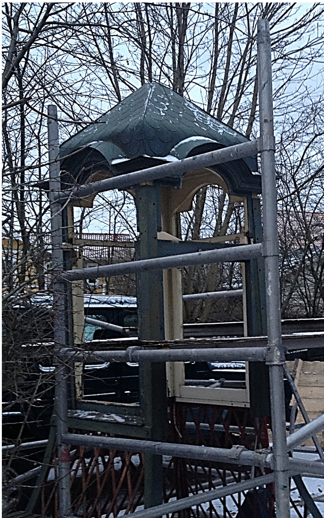
Pagoden delas i tre delar för att vissa arbeten ska kunna utföras inomhus.
