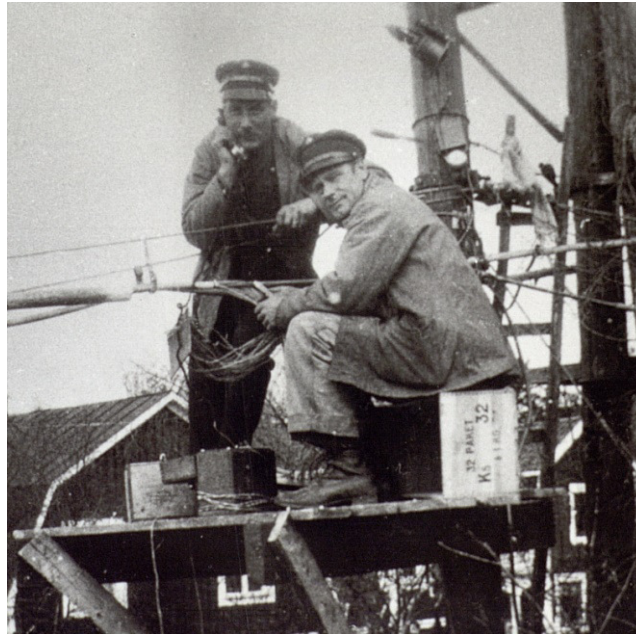
Helmer Hallenius och Per Hedlund skarvar blykabel i luftnätet från en plattform i en stolpe. Okänd plats på 1920-talet, Tekniska museet.
