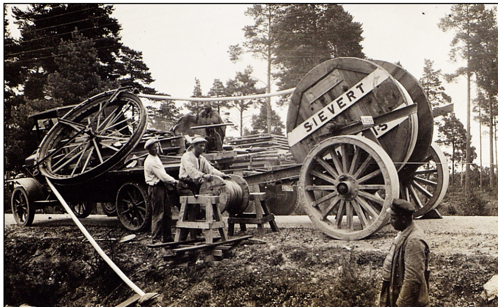
Förläggning av blykabel 1927.
