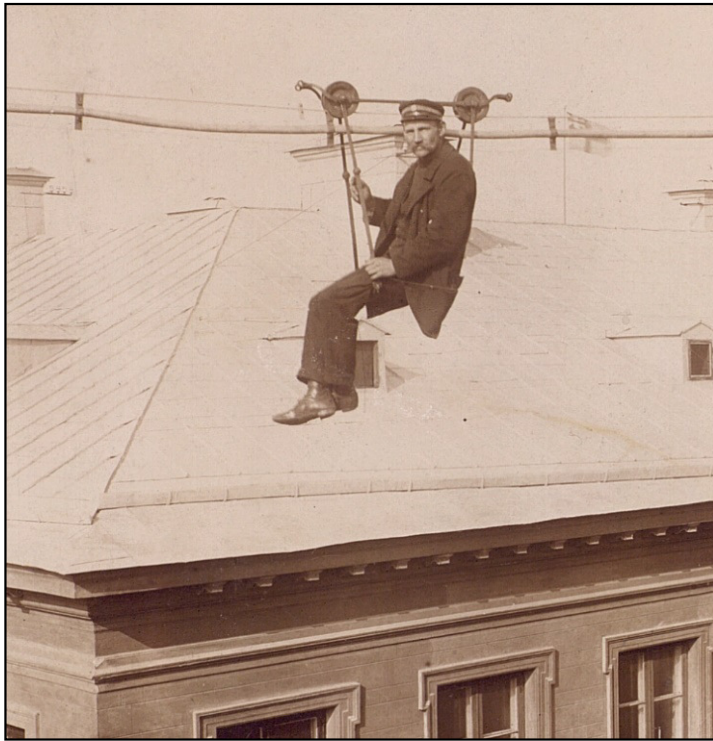
S.k. linbanevagn med sits för att laga järntråd i Televerkets luftnät. Foto från Drottninggatan i Stockholm 1899, Tekniska museet.
