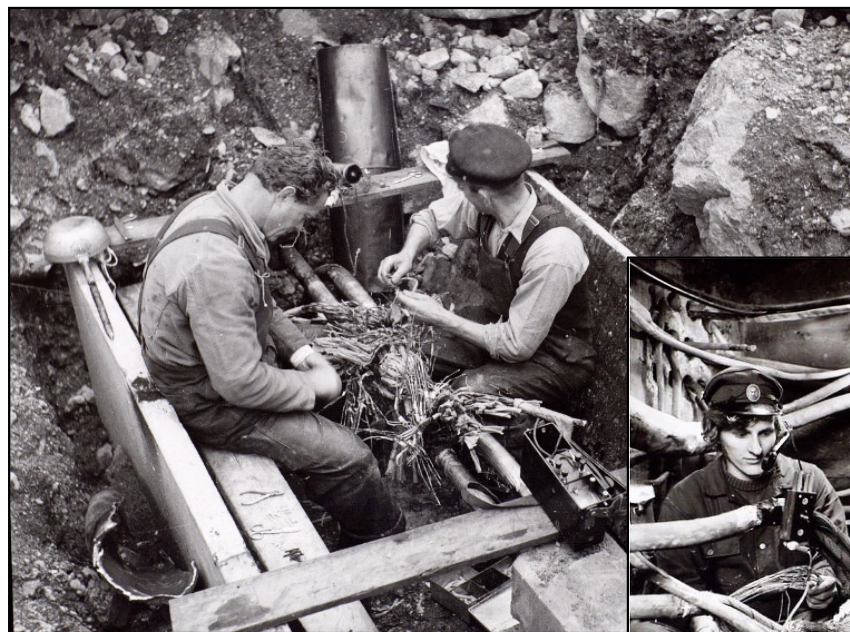
Skarvning av blykabel med pappersisolerad koppartråd.
