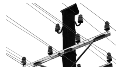
Blanktråd till abonnenterna på landsbygden fanns kvar ända fram till 1990-talet.
