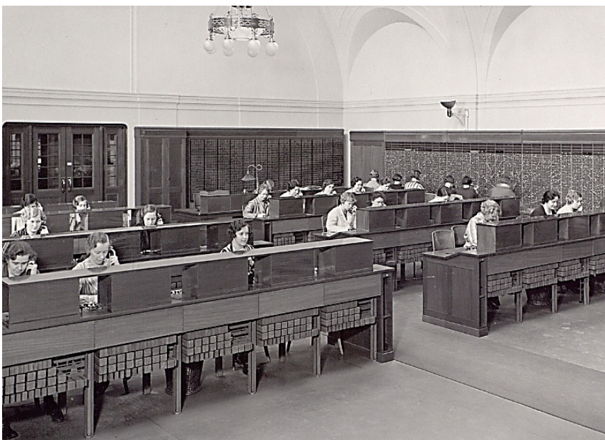
Vy över apparatsal i Stockholm. I bakgrunden samtalsräknarstativ och riksupsättningsbord för lokalstationen Centralen. Okänt år, Tekniska museet.
