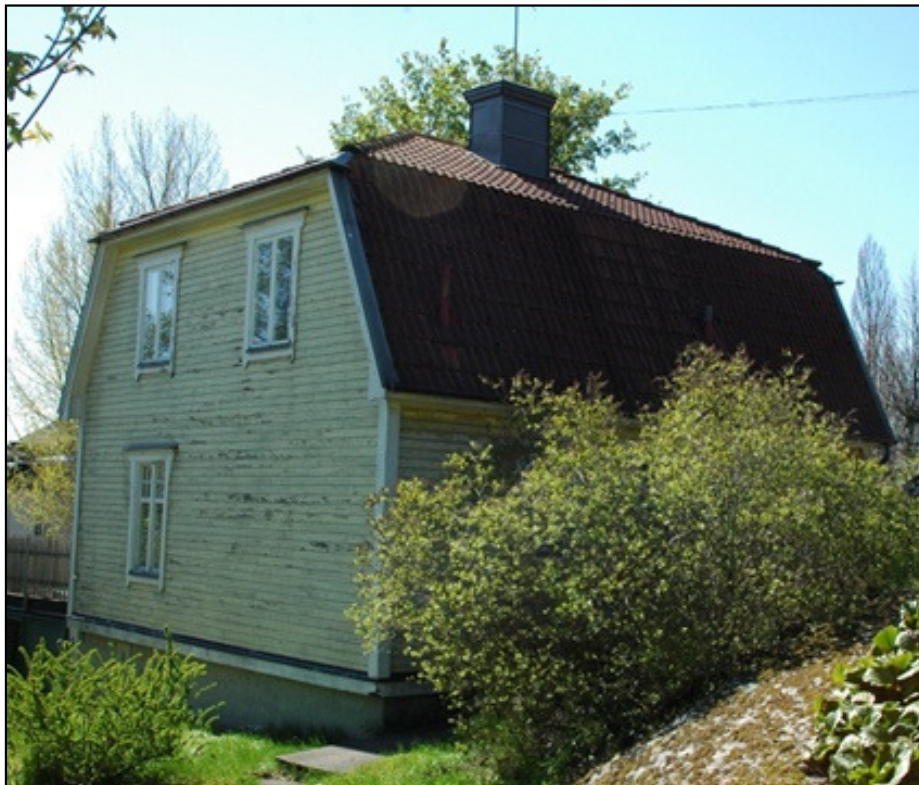
Nu rivet hus vid Baldersvägen 48.
