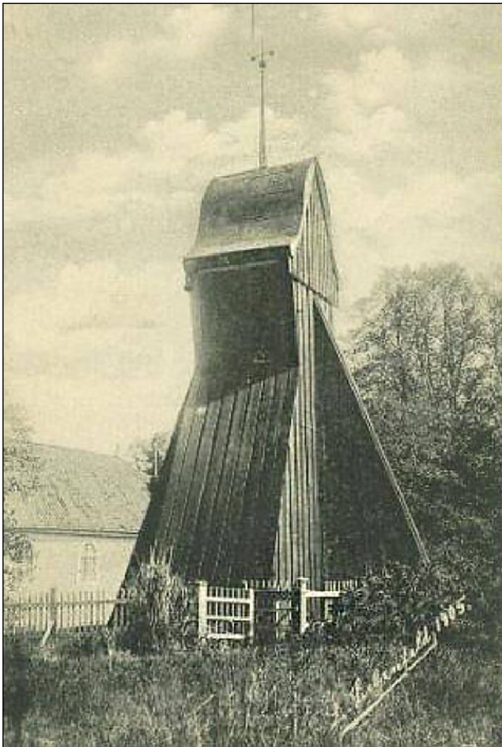
Här syns grinden mot granntomten. Det blev då närmare mellan vinterhotellet och kyrkan. Bild från 1905.
