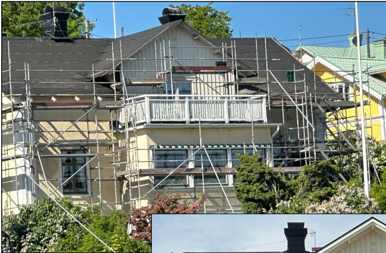
Nymålad balkong och nytt taktegel, 2023.
