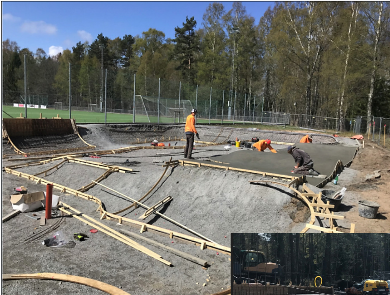
Skatebordbanan under byggnation i maj 2019.
