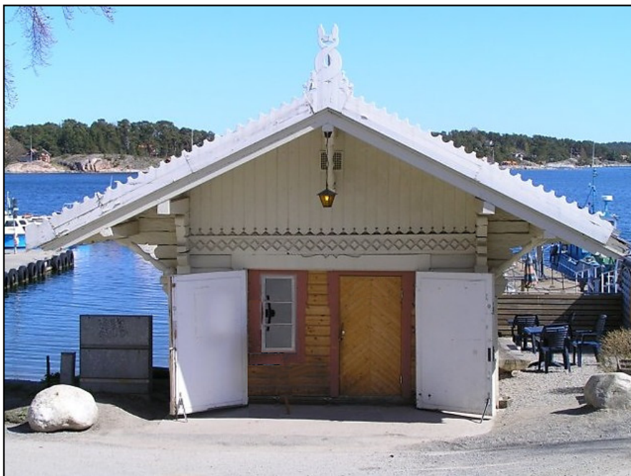
Tullbacken 4, har använts som lotsplatshus, tullvaktstuga, garage, våffelstuga och nu som kök till vandrarhemmet Lotsen. Byggsdes 1867 efter ritningar av Nils Gustav von Heidenstam.
