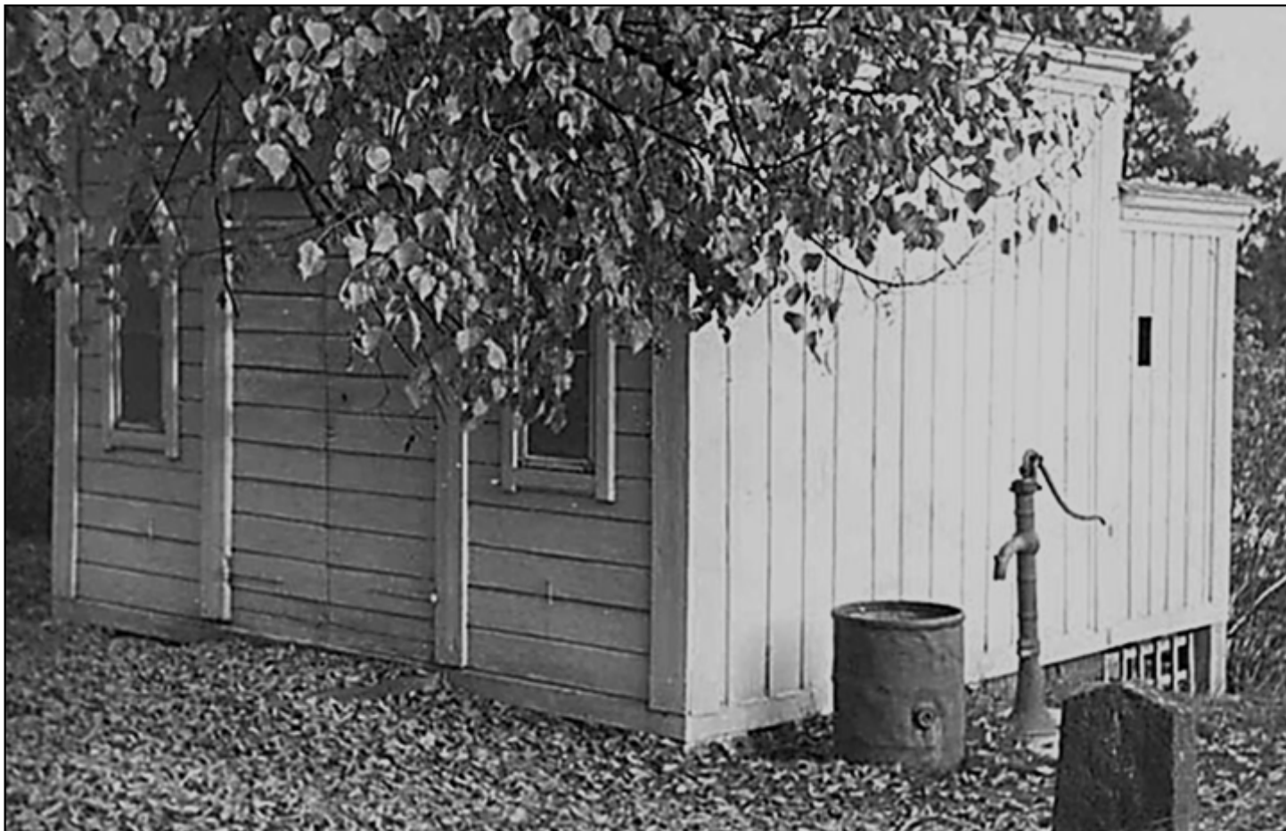
Det gamla kapellet byggdes på 1800-talet.
