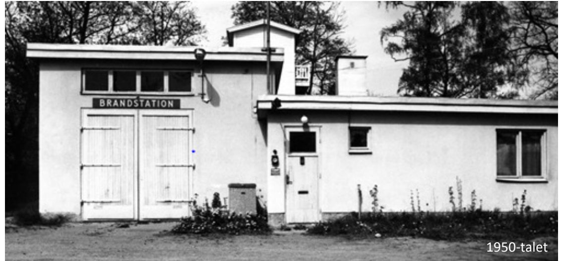
Brandstation före och efter tillbyggnad.
