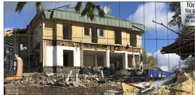
Bild från rivningen 2019.
