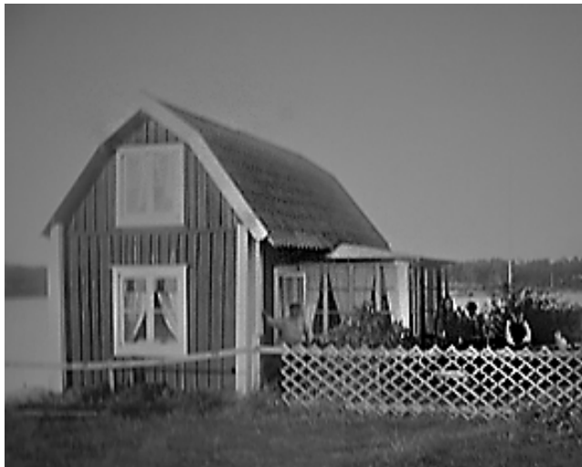
Allmogehus med påbyggd veranda.
