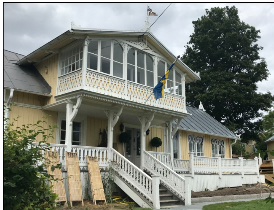
Baldersvägen 39. Ombyggnaden av den högra delen av huset blev klar och en pool byggdes framför huset. Innan ombyggnaden se SC29.
