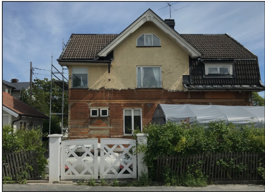
Renovering av gamla apoteket vid Odinsvägen 8 fortgår.
