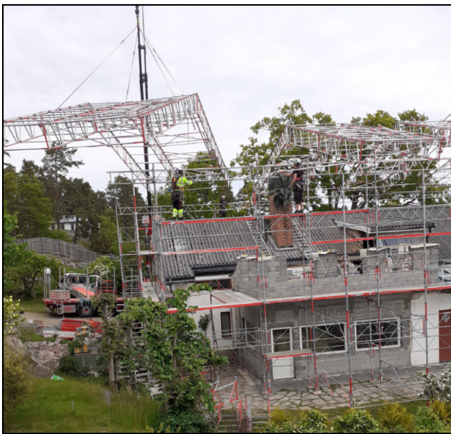
Stor ombyggnad av gamla bryggeriet påbörjas. Smådalarövägen 32. Se DHF:s redovisning SC232.
