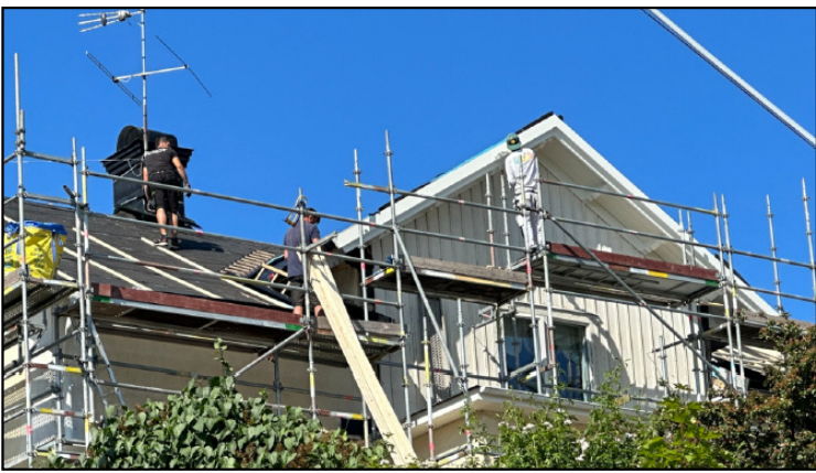
Renovering av fasad och tak på prästgården.
