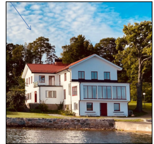
Stor ombyggnad av gamla bryggeriet fortsätter. Smådalarövägen 32. Se DHF:s redovisning SC232.
