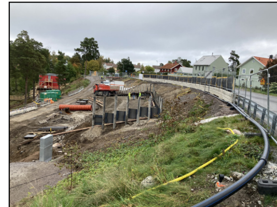
Reningsverket vid Smådalarövägen byggs ut.
