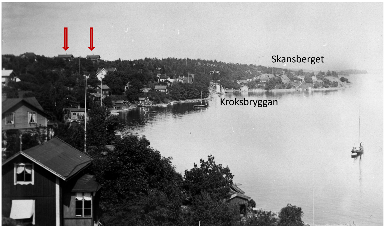
Utsikt mot Kroksbryggan och Skansberget även benämns som Eklunds udde.
