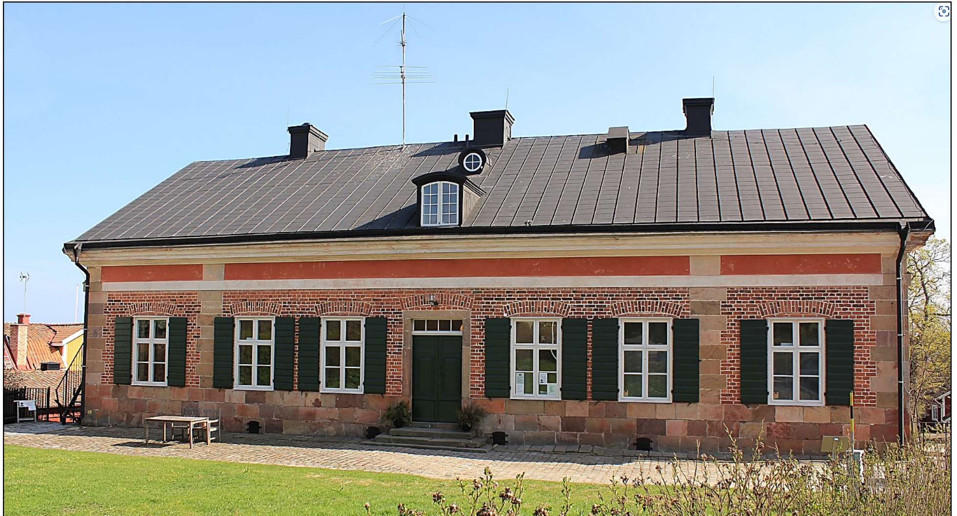
Tullhuset från sett från norr.
