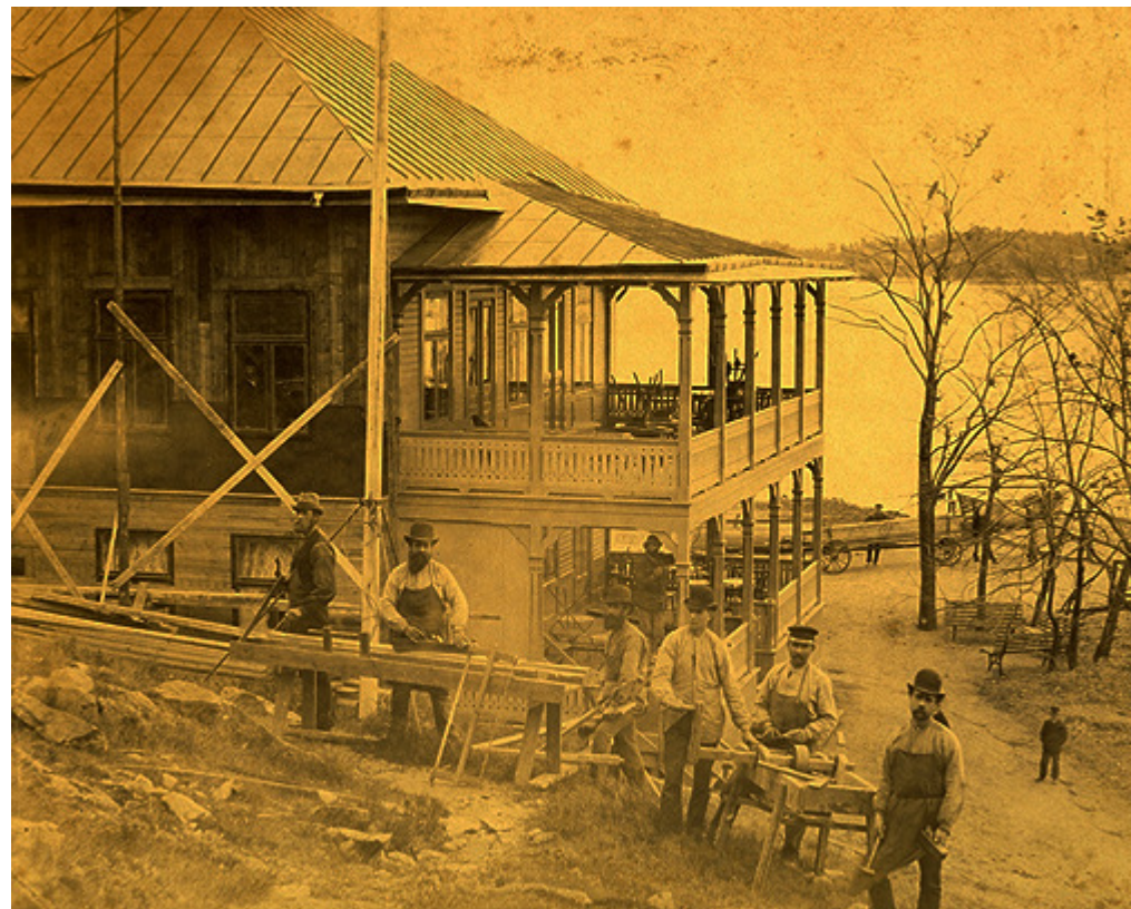
Återuppbyggnad av Dalarö Hotell efter branden 1891
