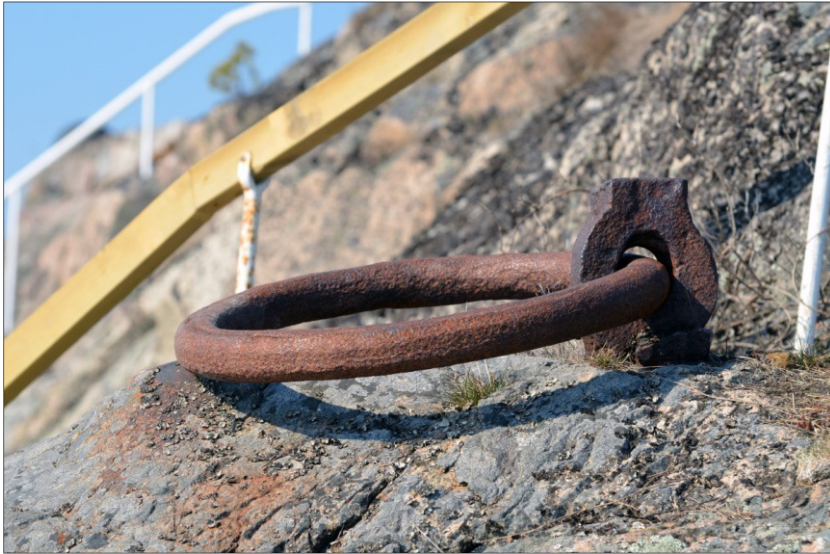
Moringen invid Lyngsåsa. Den är fastbultad på den södra delen av det branta berget. Diametern är 56 cm.
