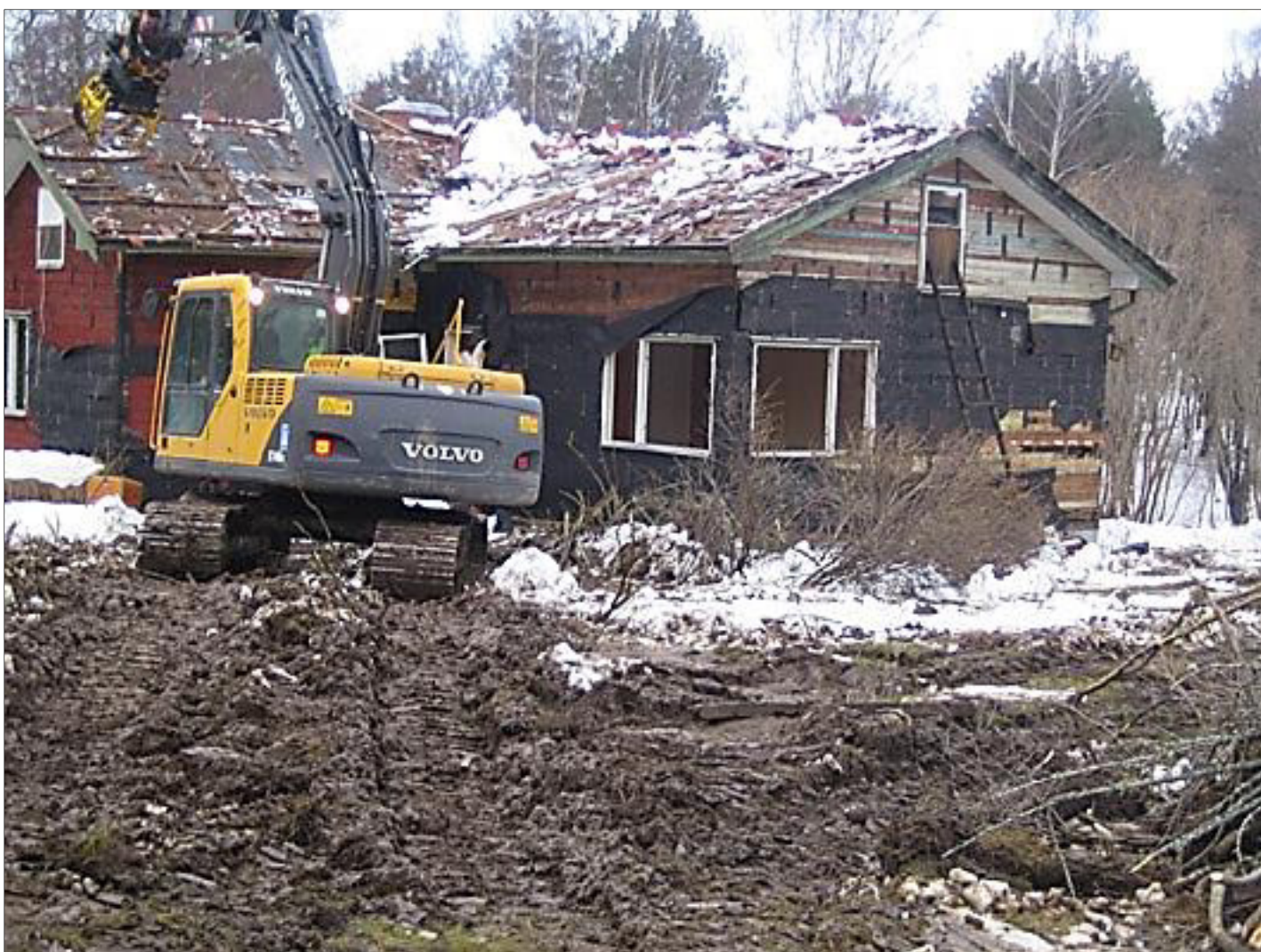
Odinsvägen 45 (Fasad mot Odinsvägen), 2011-01-19.
