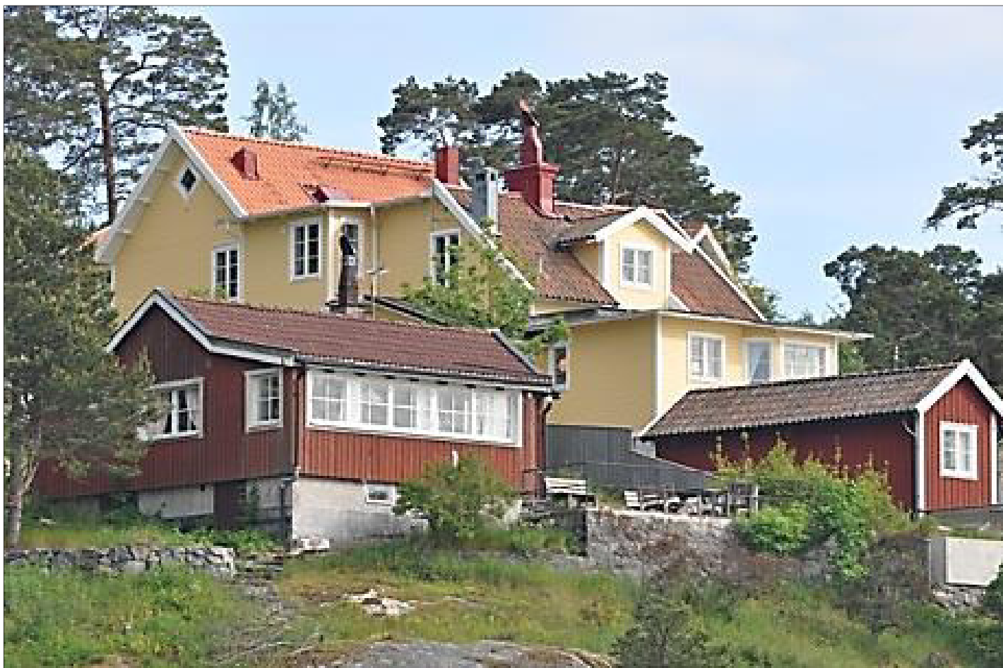
Berghamnsvägen 21 (Fasad mot Berghamnsvägen), 2012-06-15.
