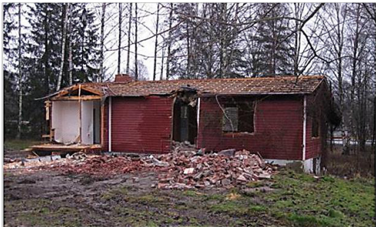
Kanalvägen 1: Dalarö 3:59 (Rivning av befintlig byggnad) 2009-01-20.
