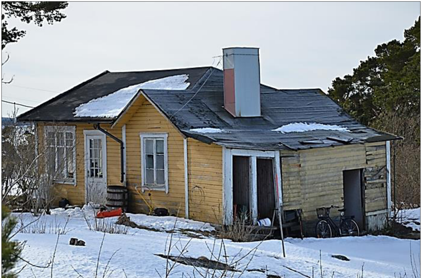
Birger Jarlsvägen 3A, Dalarö 2:72, 2013-03-20. före rivningen.
