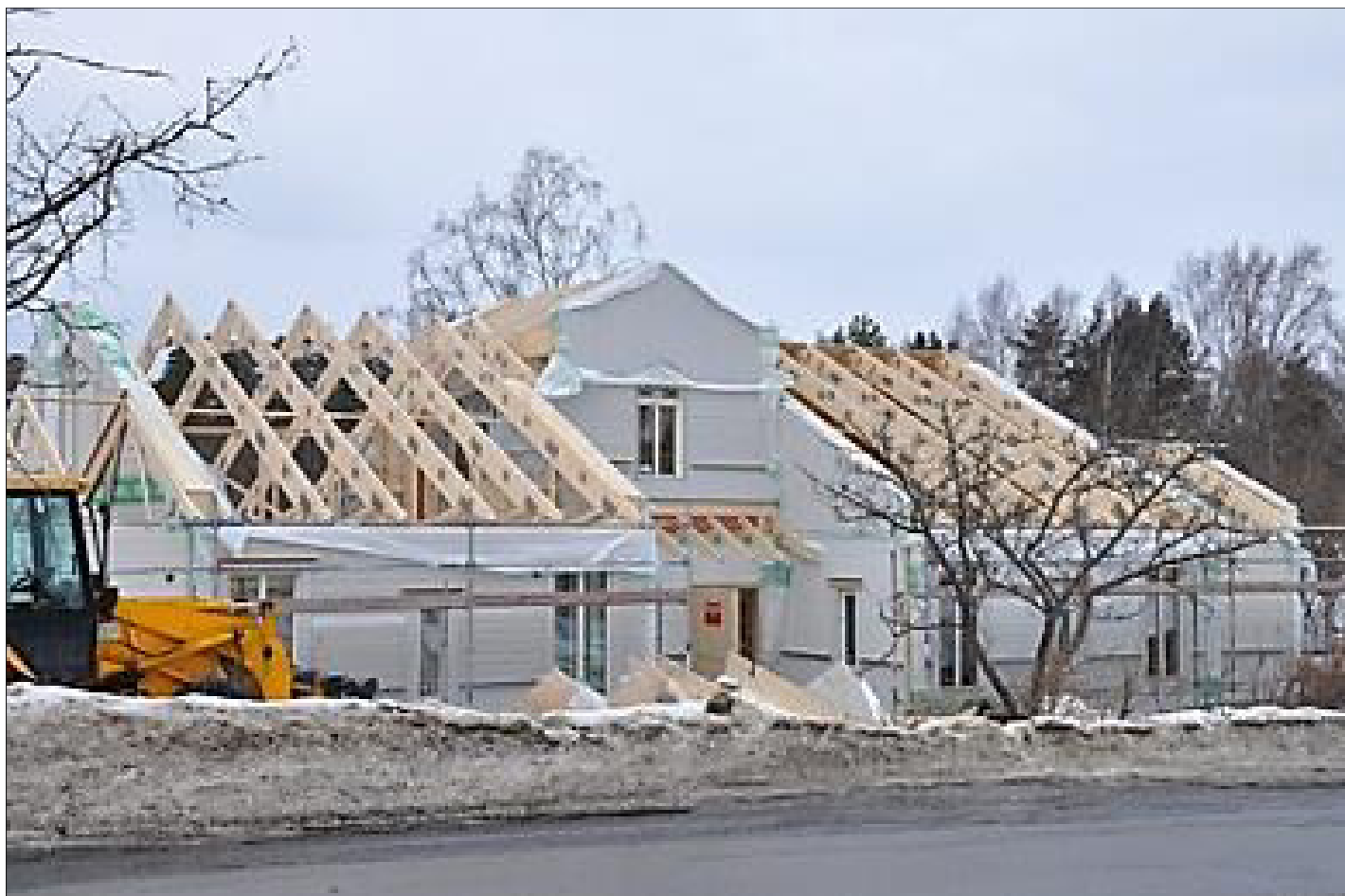
Odinsvägen 45 (Fasad mot Odinsvägen), 2011-03-04.
