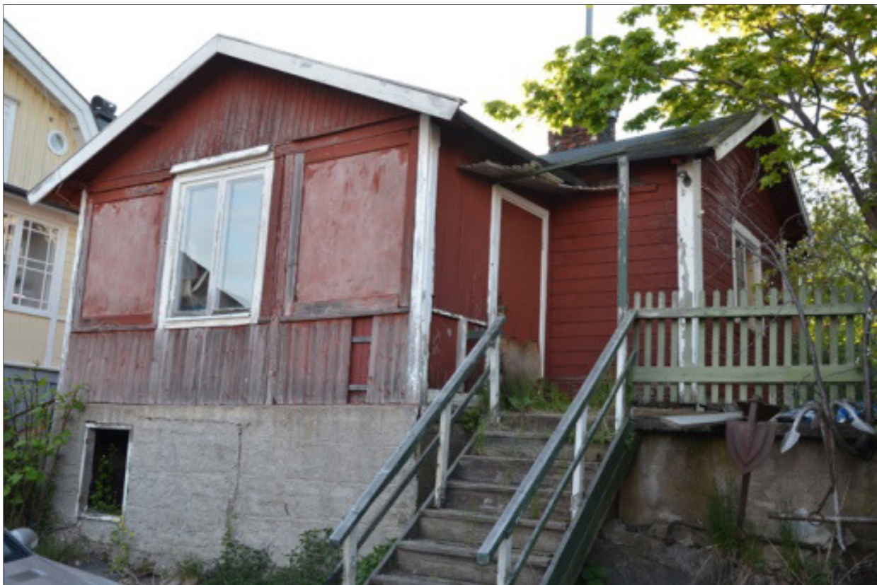
Odinsvägen 13, Dalarö 2:111, 2015-04-10, före rivningen.
