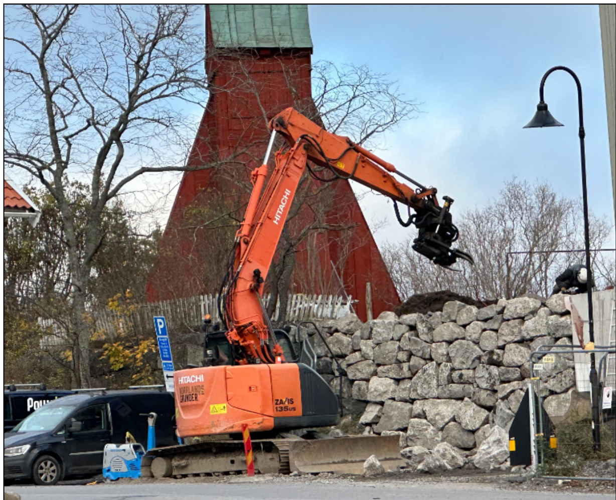
Stenmuren vid klockstapel byggs åter upp.
