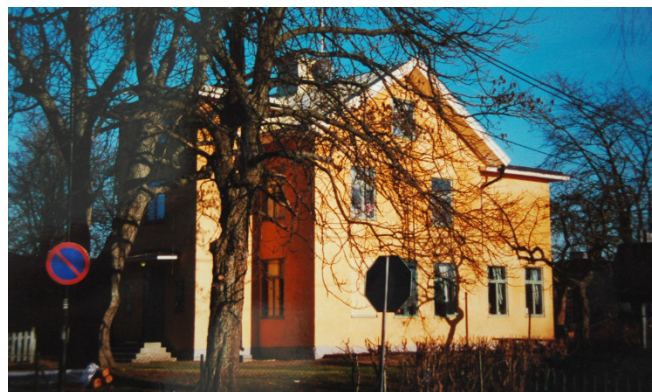
Baksidan där glasverandan tidigare fanns. Foto 1996.
